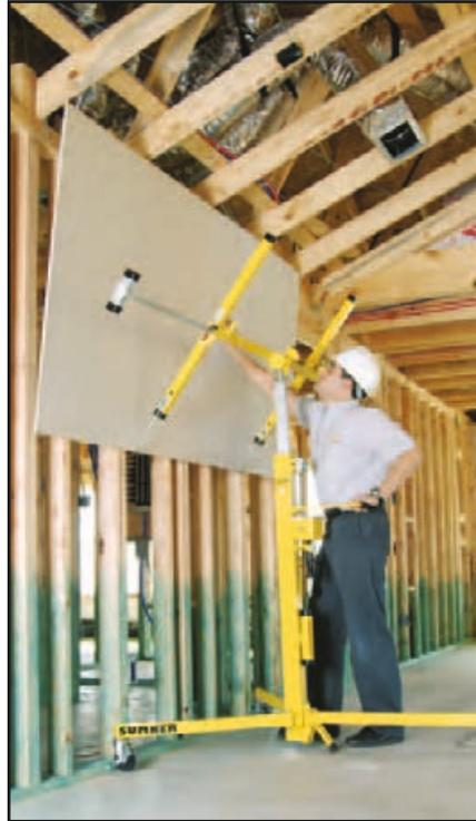
Steuerhebel führt zu optimaler Positionierung.
